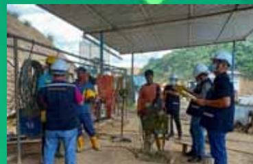
Pegawai yang terlibat sedang memeriksa pekerja bukan pemastautin dari negara Bangladesh yang sedang bekerja di sebuah bengkel berdekatan dengan tapak pembinaan Empangan Baleh
